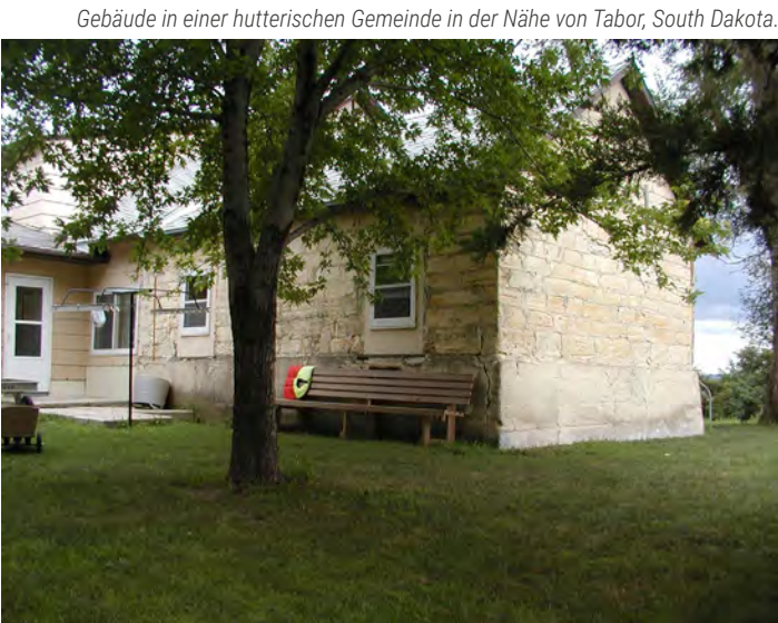
Gebäude in einer hutterischen Gemeinde in der Nähe von Tabor, South Dakota.
